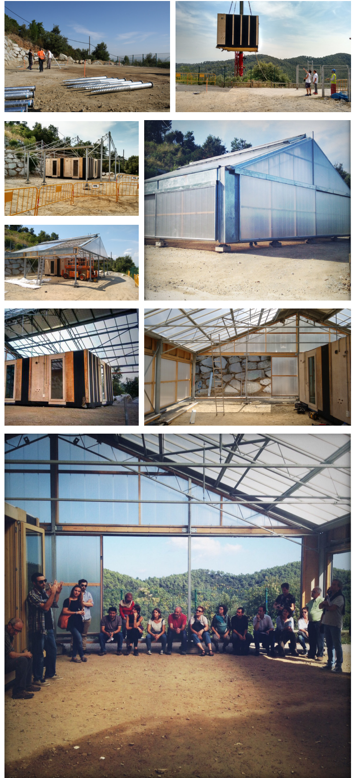
III etapa_Plataforma (e)co: Laboratori Urbà de Producció Col·lectiva, Les Planes.
