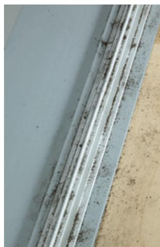
Polvo de la construcción, granos de arena, pelos de animales. La suciedad siempre se deposita, ya sea durante la instalación o durante el día a día. Al depositarse sobre el carril se convierte en un perturbador freno, que poco a poco daña las ruedas de los carros, impidiendo el suave funcionamiento de los mismos.
